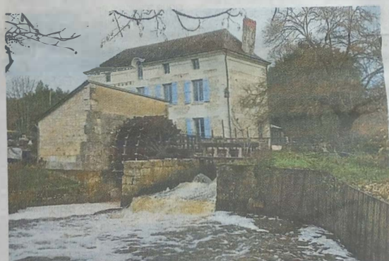
La prise d'eau du moulin se situe dans un canal de dérivation de la Claise et un canal de fuite reconduit l'eau à la rivière.
